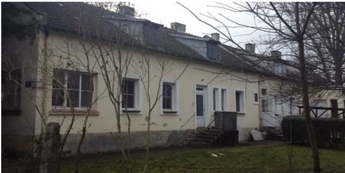
Bild oben: Das „Werkmeisterhaus“ von 1884 in der Lagerstraße 11; Foto © Gisela Sollak
